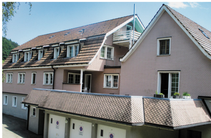
Das ehemalige Restaurant «Brauerei» in Heiden befindet sich im Eigentum des Kantons, der eine Vermietung der derzeit leeren Lokalitäten anstrebt. (Bild: Peter Eggenberger)
